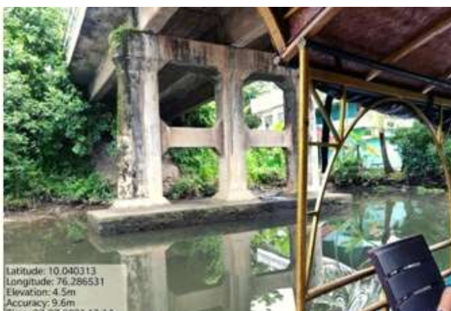
Siltation beneath Edayakkunnam bridge
