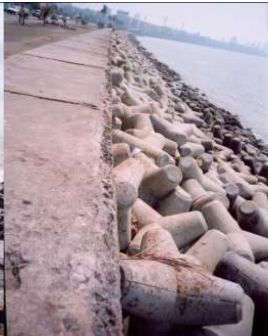
(d) Seawall at Marine drive, Mumbai
